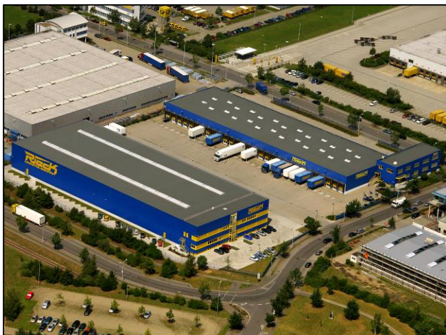
Luftbildaufnahme der Niederlassung Dresden Foto: Rieck
